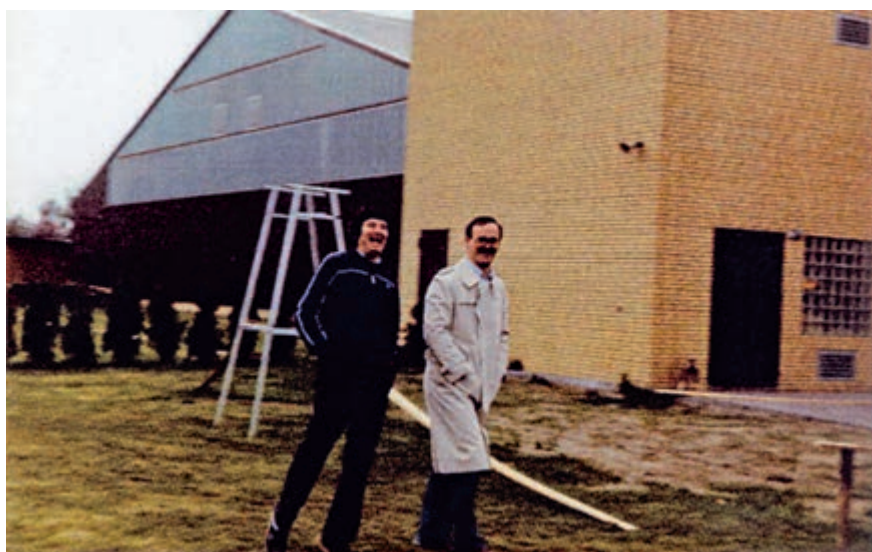
Dieter Nagel und Franz Josef Sievers besichtigen die Baustelle 1990.
